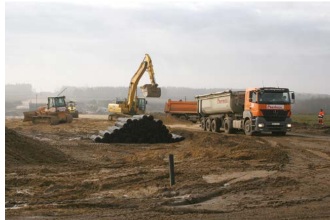
13.11.2009 r. - budowa obwodnicy
