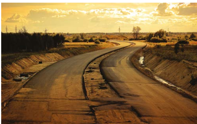
5.09.2010 r. - budowa dwujezdniowej obwodnicy Serocka fot. L. Błachnio
