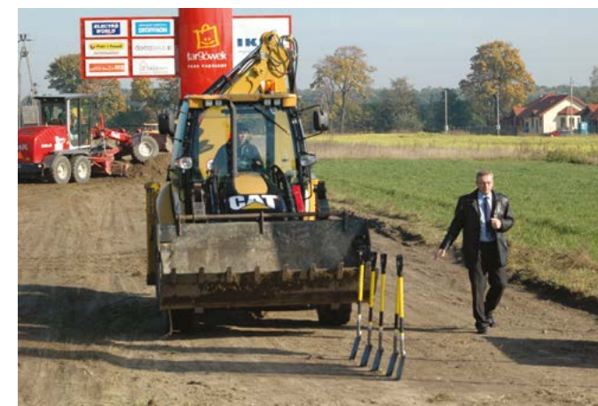
15.10.2007 r. - wbicie łopat pod rozbudowę drogi kr 61
